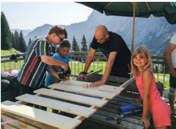
Die Lattenroste für das obere Lager in der Willi-Merkel-Hütte werden zusammengebaut.
