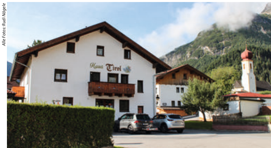
Die „Haus Tirol“ in Vorderhornbach hat eine wechselvolle Geschichte. 1945 wurde die Dorfkirche bei einem Brand zerstört, der auch das „Haus Tirol“ in Mitleidenschaft zog. Alle Fotos: Rudi Nägele
