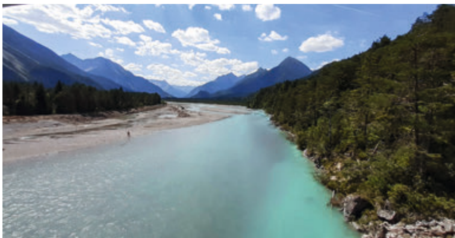
Eine beeindruckende Aussicht bietet die Hängebrücke bei Forchach auf das Flussbett des Lechs und in die Bergwelt Richtung Warth. Foto: Monika Lixl
